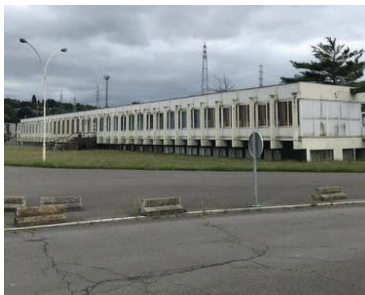
Le bâtiment sera restauré ou démolé et reconstruit. © L.G.
